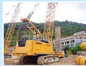
磨樁機運作中
