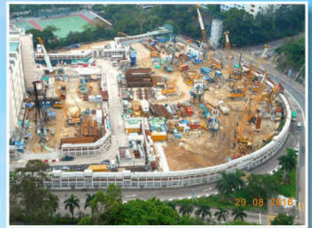
新日間醫護大樓地盤 (攝於 29-8-2016)
