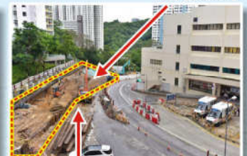
閘板裝置進行中 (攝於 8-9-2016)
