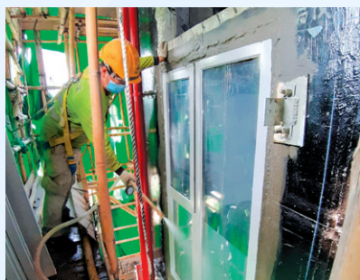
大樓的窗戶已經安裝完成，並由工人進行漏水測試。
