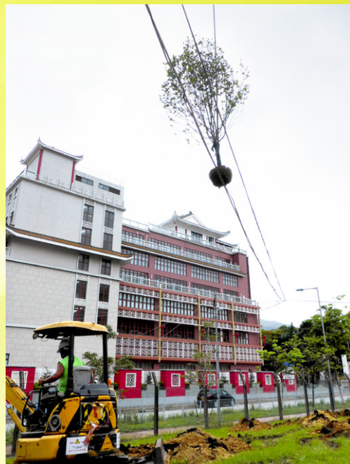
樹木須由工程車吊運至種植的地皮上。
