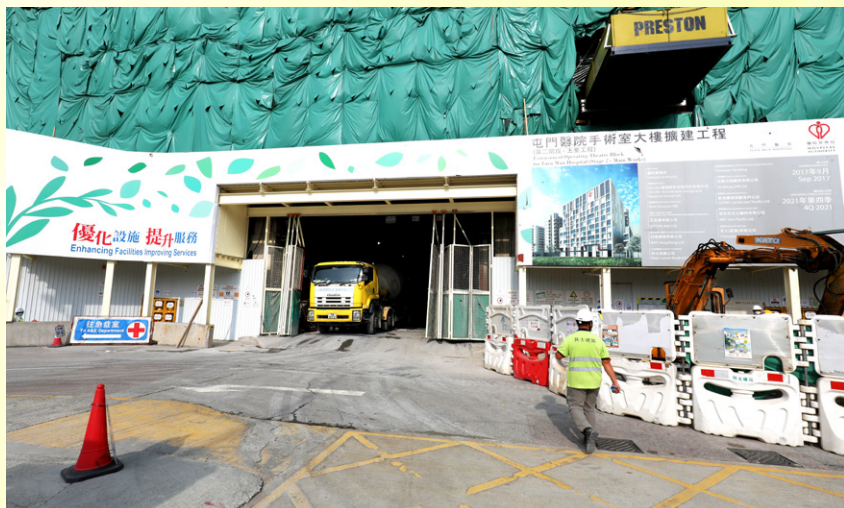
手術室大樓工地對出的路段，正進行挖掘工程。
