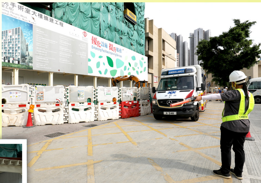
承建商安排了職員，在改道的路段指揮交通。
