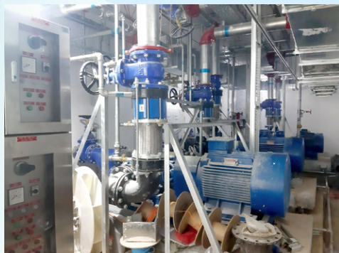
地庫樓層正安裝機電設施及進行內部裝修。
