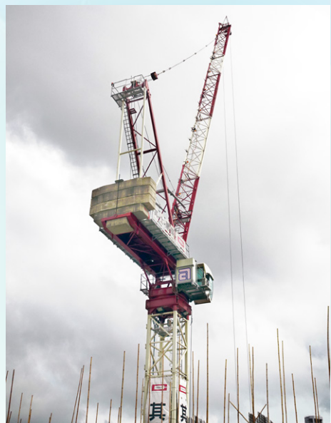
現有天秤稍後將會拆卸，並改裝另一組吊重機以配合工程進一步推展。
