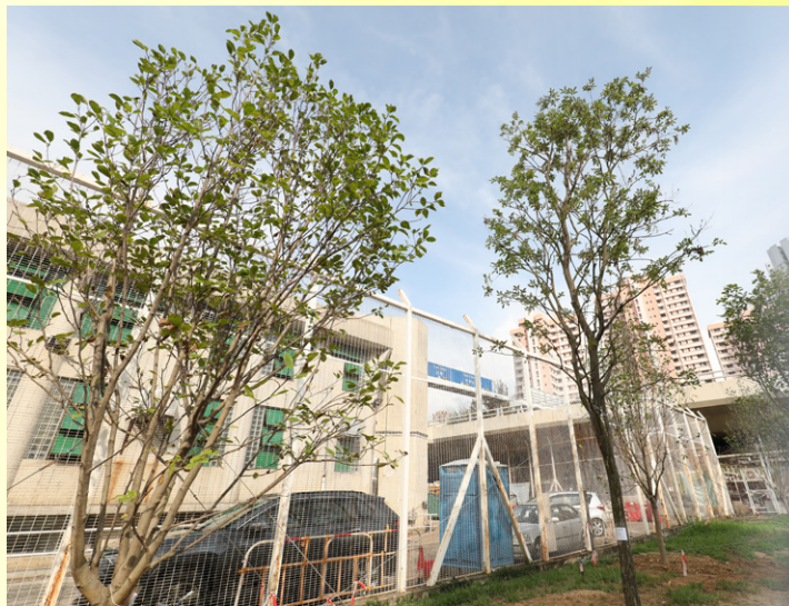
新樹種植在屯門醫院洗衣房對出，面向青松觀路。
