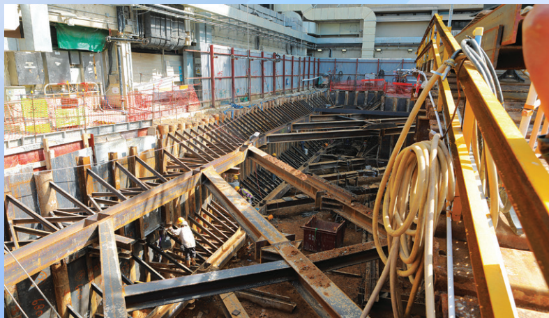
工程承辦商正在挖掘地下空間，以便日後興建新手術室大樓的地庫。
