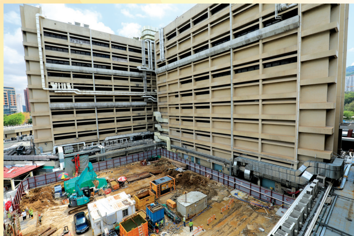
屯門醫院手術室大樓的地基工程已經完成，工程承辦商隨即開展大樓的主體工程。
