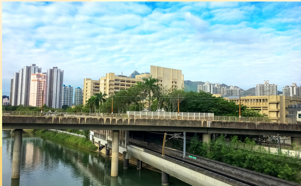
大樓內部設計將會引入屯門區的社區元素，如屯門河等，讓大家對大樓更有歸屬感。
