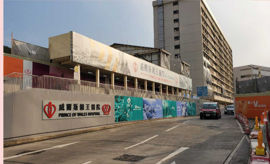
位於銀城街車道入口旁的「臨時工作大樓」正進行部分拆卸工程，有關道路的改善工程亦預期於2024年第2季進行。
