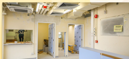
錦田診所內部翻新工程進行得如火如荼，翻新後候診室增設空調，大大改善診所環境。
