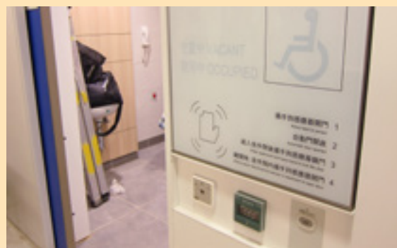
暢通易達洗手間設有感應系統
