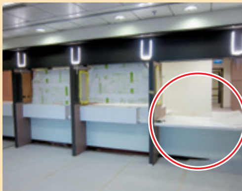
(左圖) 藥劑部設立低櫃位 (圓圈位置)，(上圖) 櫃位旁邊均設有一個「J字型」的凹位方便傷健人士。
