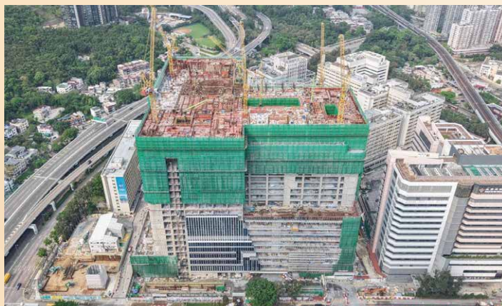
威院重建計劃工程進展（2026年4月）
