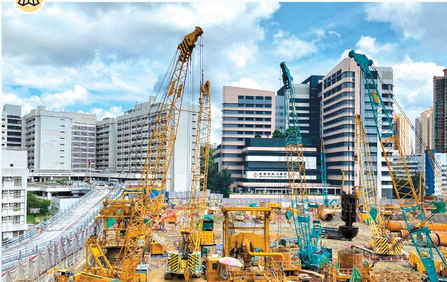
威院重建計劃現正全面進行地基樁柱工程，承建商一直採用較寧靜的施工方法，在地盤圍板上加裝隔音屏障。
