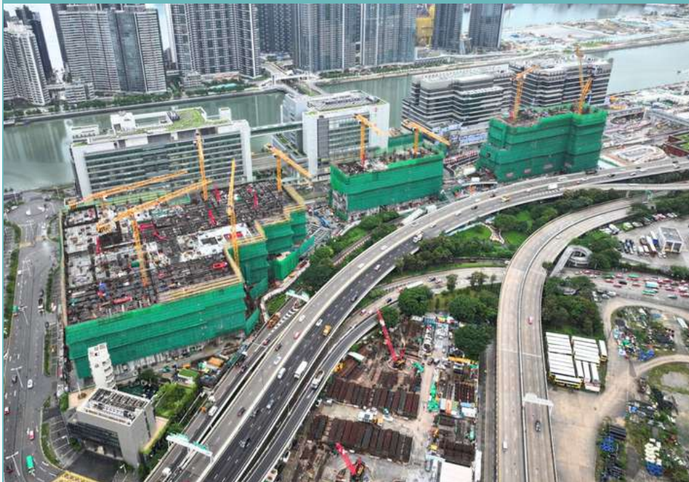
急症大樓、行政大樓和教學及培訓大樓 2025年8月
