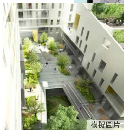
部份大樓的平台設有綠化區域。
