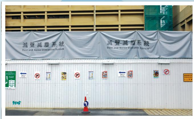
地盤裝設「減聲減塵系統」，減低嘈音及減少塵埃的飛揚
