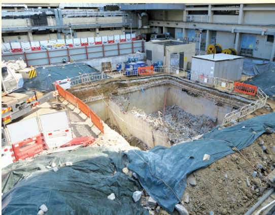
地底油缸已遷移，稍後會開展地基工程。
