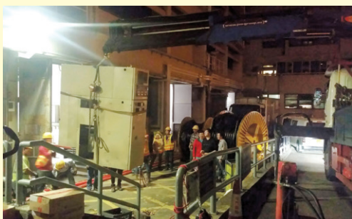
工程人員密鑼緊鼓置換電力掣櫃
